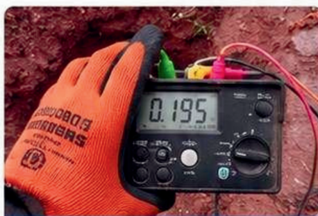
MEDICIÓN DE RESISTENCIA DE POZO A TIERRA
