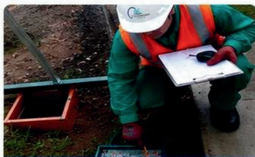
MEDICIÓN DE POZO A TIERRA
